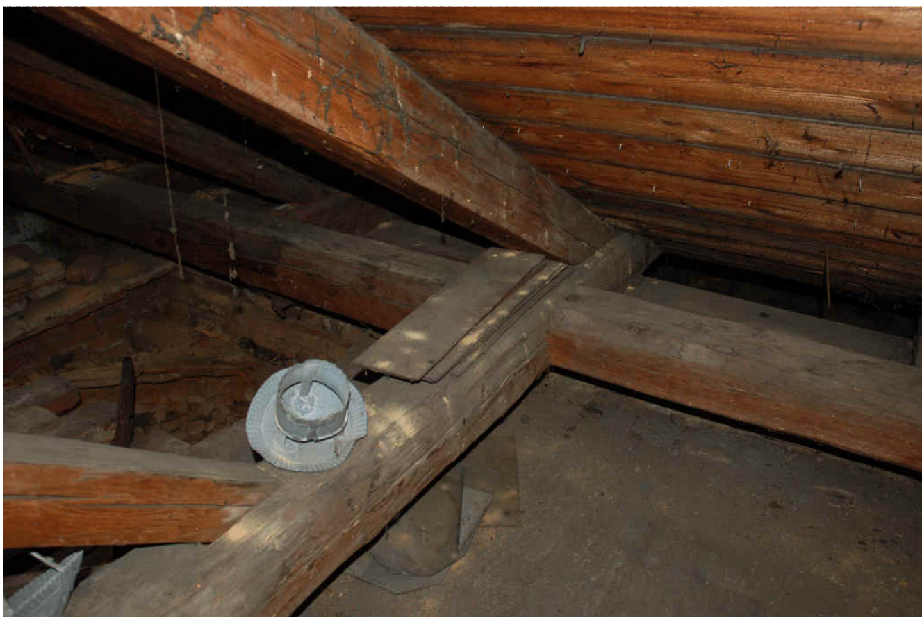
Obr. 2 Čerstvé výměsy larev dřevokazného hmyzu z čeledi TESARÍKOVITÝCH na povrchu dřevěných prvků svědčící o aktivní přítomnosti larev ve dřevě.
