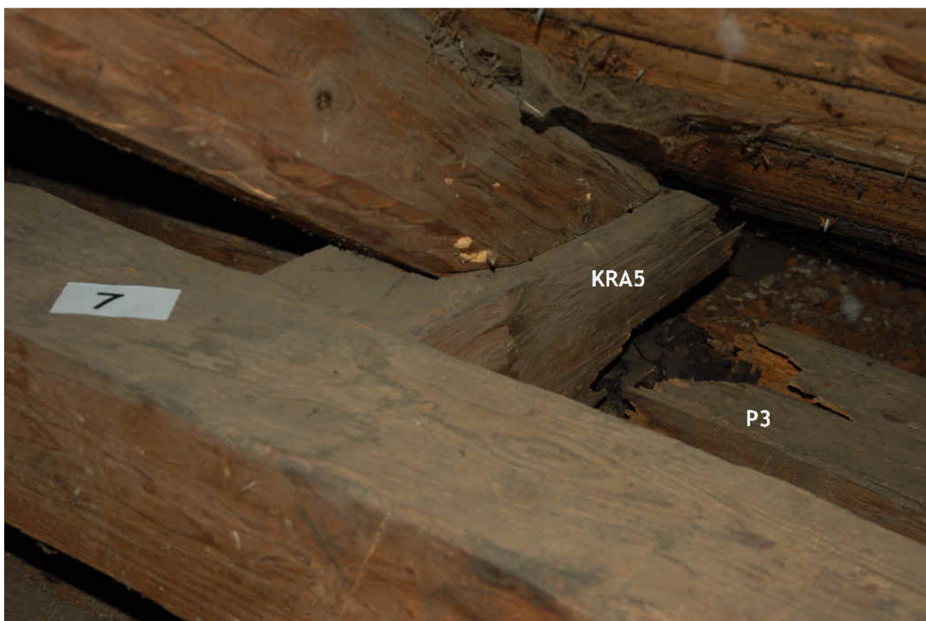
Obr. 2 Totální destrukce krátkete a dřevěného prahu hnědou hnilobou a dřevokazným hmyzem z čeledi ČERVOTOČOVITÝCH.
