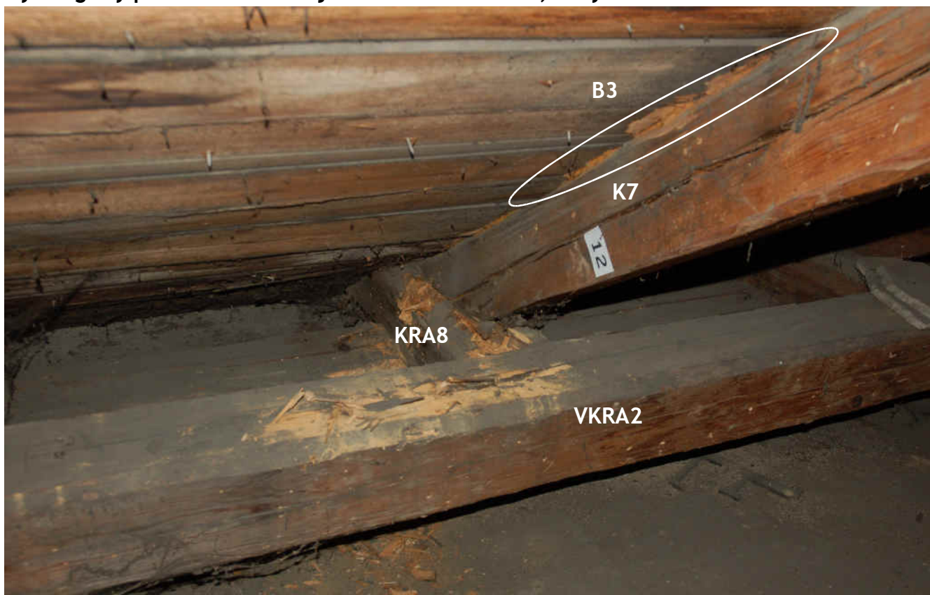
Obr. 1 Hlubkové poškození krátkčete, výměny krátkčat a krokve hnědou hnilobou a dřevokazným hmyzem - stav po provedení kontrolních vpichů. Na krokvi a bedněni je zřetelná plodnice dřevokazné houby z čeledi CHOROŠOVITÝCH.
