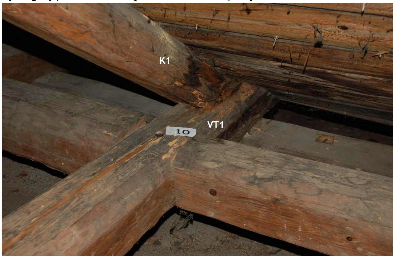
Obr. 1 Hlubkové poškození zhlaví vazného trámu a krokve hnědou hnilobou a dřevokazným hmyzem - stav po provedení kontrolních vpichů.
